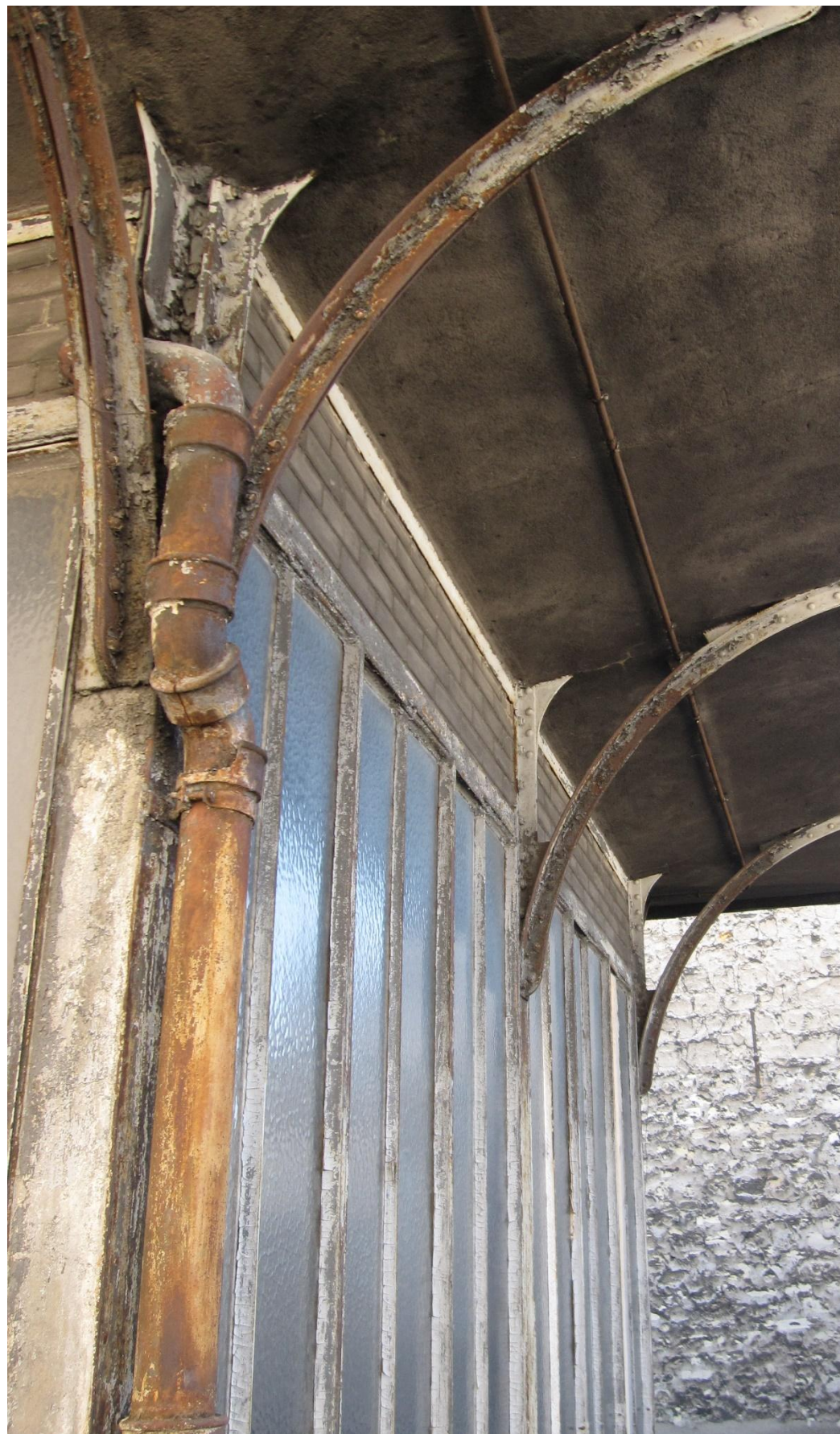
Fotografie dei particolari costruttivi della Centrale Voltaire
